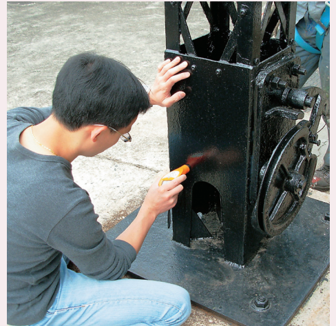
▲ 我们完成修复处理后，量度油漆的乾膜厚度
